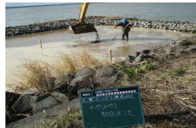
土砂投入(傾斜地の造成)
