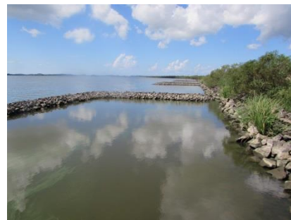
対策実施前 ※植生回復が進んでいない
