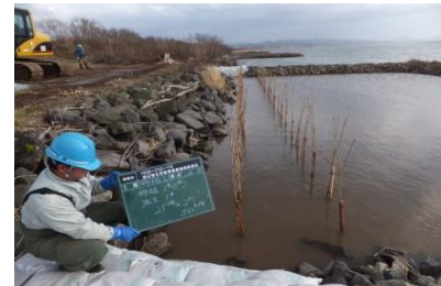
水生植物の移植後
