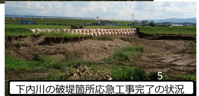
下内川の破堤箇所応急工事完了の状況
