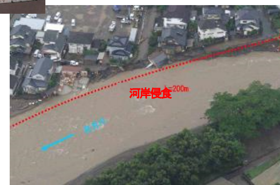
河岸侵食に伴う 家屋倒壊等
