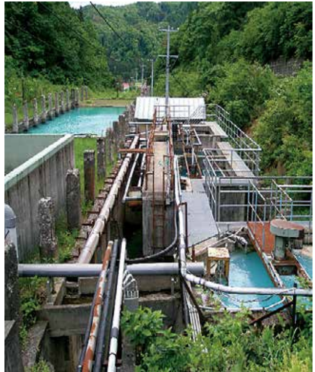
吉乃鉱山（横手市）坑廃水処理施設
