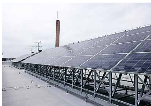
県庁舎に設置した太陽光発電設備
