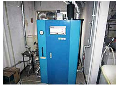
高効率ボイラーの更新による省エネ改修の事例
