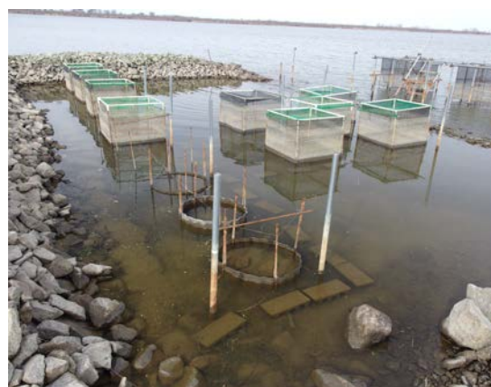
写真 4 夜叉袋消波堤 No.9 の汚濁状況 (平成 26 年 11 月 25 日)
