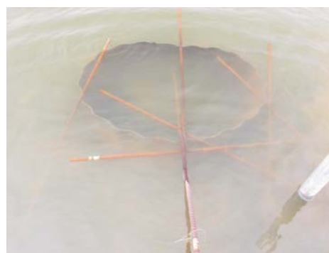
写真5 氷の氷解により倒れた鉄筋(平成26年3月26日撮影)
