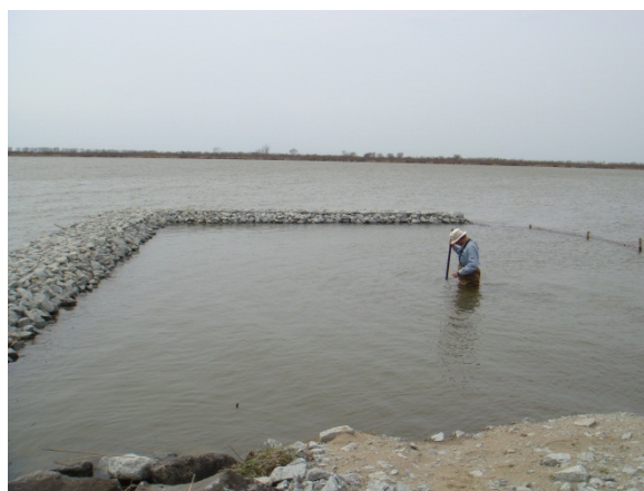
写真 2 夜叉袋 L 字型消波堤 No 9 (平成 22 年 4 月)
