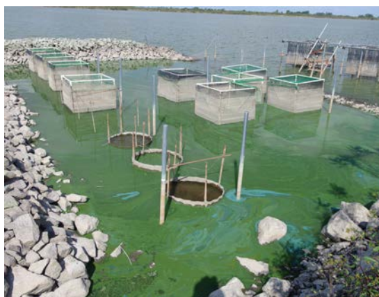
写真 3 夜叉袋消波堤 No.9 の汚濁状況 (平成 26 年 9 月 30 日)
