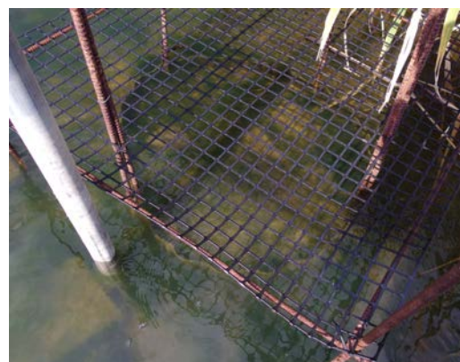
写真13 消波堤 A のトリカルネット設置区 (南側、平成 26 年 10 月 15 日)
