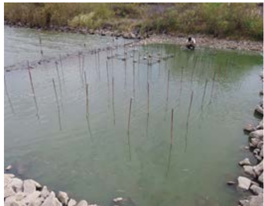
写真 33 消波堤 No. 7 に移植した 3 種類の沈水植物のマット苗は生育確認できず (平成 26 年 9 月 30 日)
