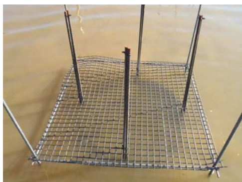
写真4 鳥害防止のためトリカルネットを設置(設置時の写真)
