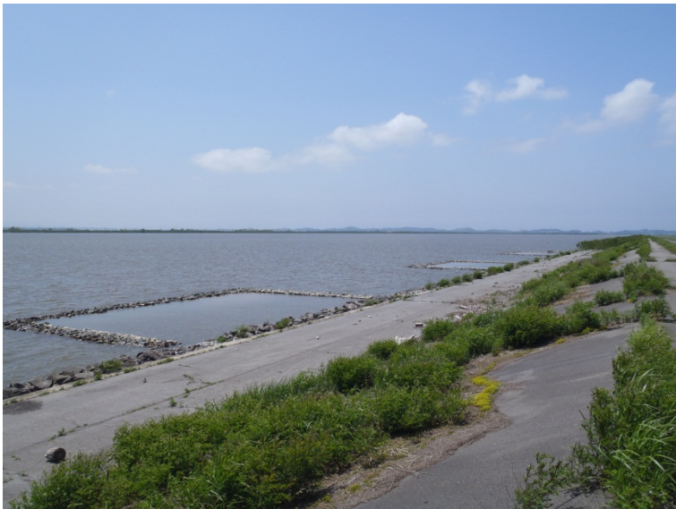
写真8 東部承水路内の牡丹川 消波堤(6月4日撮影)
