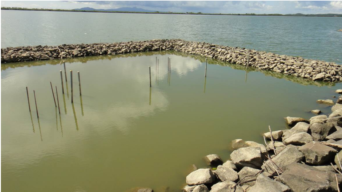
写真9. タイプD-2の様子（平成26年9月13日撮影）水が濁り、湖底は見えない。
