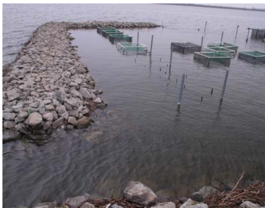
写真 1 夜叉袋消波堤 No.9 の汚濁状況 (平成 26 年 4 月 28 日)
