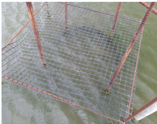
写真10 消波堤 B-1 のトリカルネット設置区 (南側、平成 26 年 9 月 30 日)
