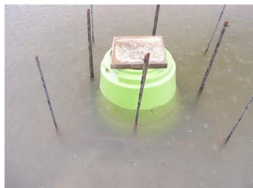
写真2 散布体バンクの拡散を防ぐためコンポスターを1日設置(平成25年12月4日)
