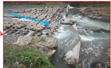
川床低下・床止工の倒壊
