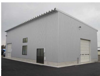
TMRセンター全景
