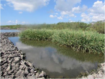
対策実施後 ※植生回復が進んでいる
