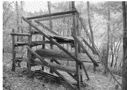
フィールドアスレチック遊具更新 [中央公園]
