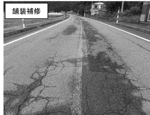
国道105号（大仙市 大曲西根工区）
