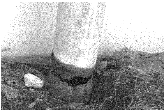
①イサノ住宅（ドレン管）
