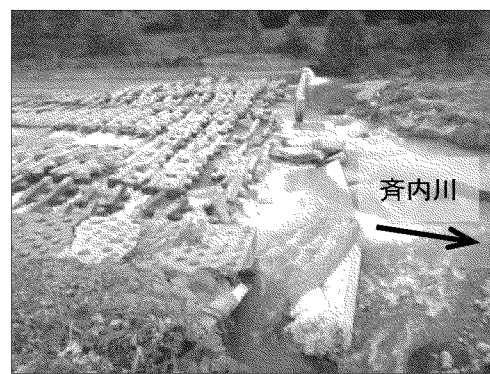
斉内工区 落差工・護岸工・護床工
