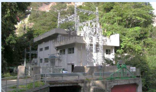
素波里発電所
