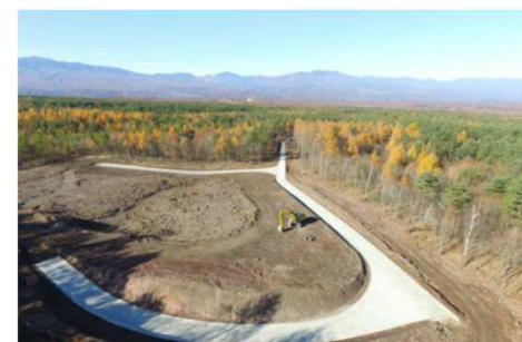
写真-1 工事用道路整備事例※1
