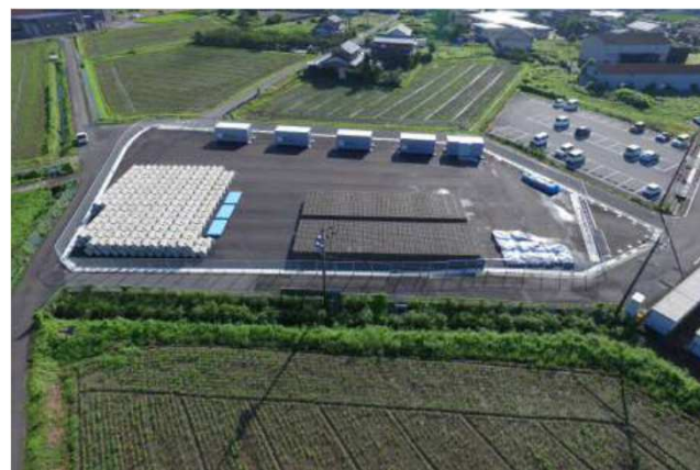
写真-1 整備された備蓄拠点※2
