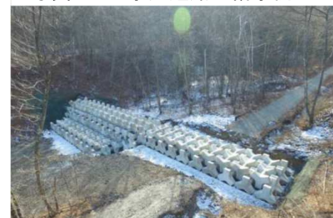
写真-2 ブロック堰堤整備事例※1
