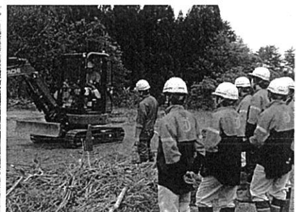
バックホー操作実習
