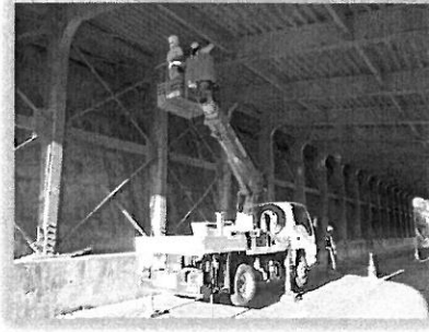
道路施設点検
