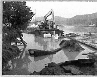
災害復旧作業
