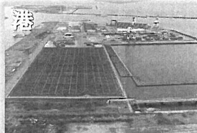
秋田港(国際コンテナターミナル)
