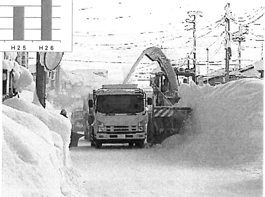
県道の除雪 (平成26年1月 横手市)
