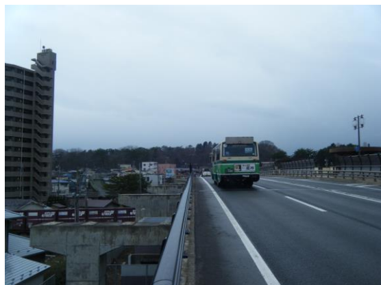
【橋梁の総合的な拡幅・耐震補強等により防災性能向上】
