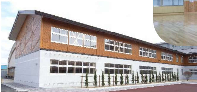
能代松陽高等学校 教室棟 外観
