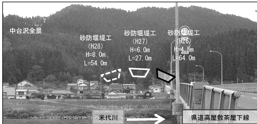
中台沢（能代市） 砂防堰堤工
