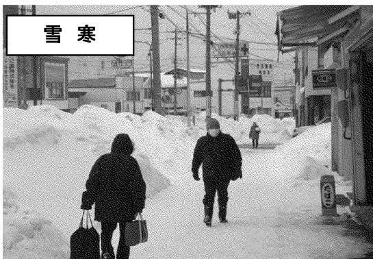
○歩道無散水施設設置
