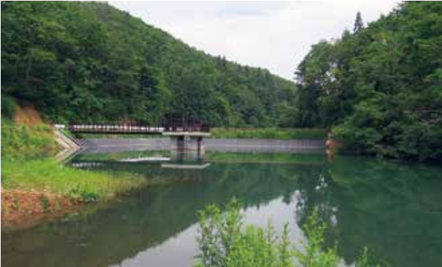
【ため池等整備】 老朽化ため池の改修 岩の沢地区（湯沢市）
