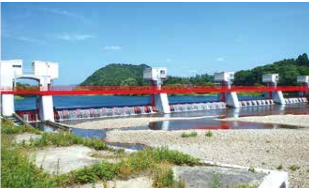
【農業用河川工作物応急対策】 頭首工の改修 立花（大館市）
