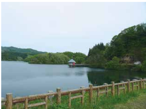
耐震補強が必要なあいののダム及び取水塔
