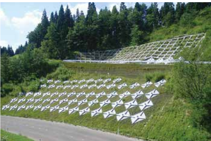
法面の保護整備 堪忍沢地区（鹿角市）
