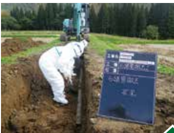
アスベスト管の撤去
