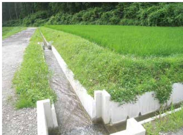
用排水路整備 小川口地区（五城目町）
