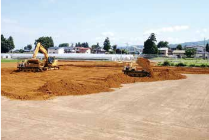
客土整備 亀福一期地区（横手市）
