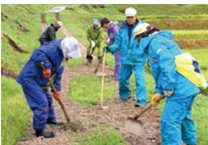
農道の砂利敷 横岡地区（にかほ市）
