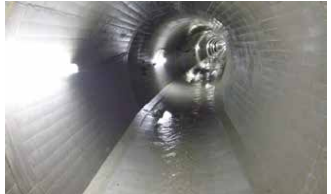
【用排水施設整備】 水路トンネルの改修 一ノ目瀧地区（男鹿市）
