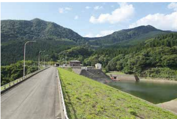
ダム施設の更新 水沢山地区（八峰町）
