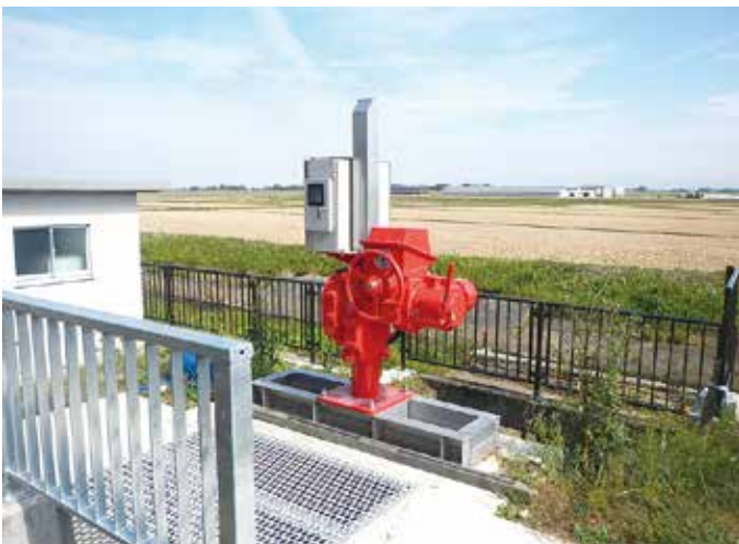
ゲートの更新（電動化） 羽後地区（羽後町）
