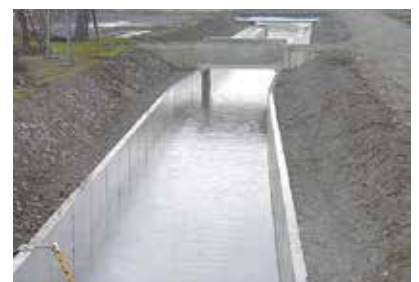
皆瀬1号幹線用水路
