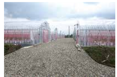
トマトハウス団地 中仙中央地区（大仙市）
