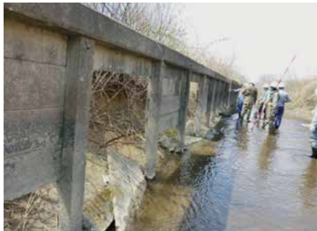
老朽化している支線排水路
