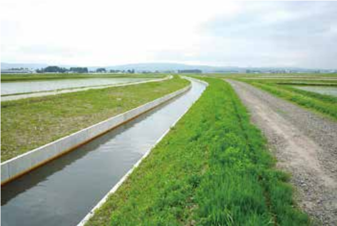
幹線用水路の改修 平鹿平野一期地区（横手市）
