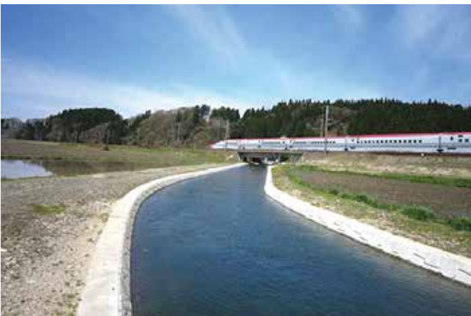
幹線用水路の補修 仁井田地区（秋田市）
