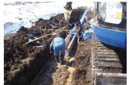
農業用水路の更新 下川原地区（鹿角市）
