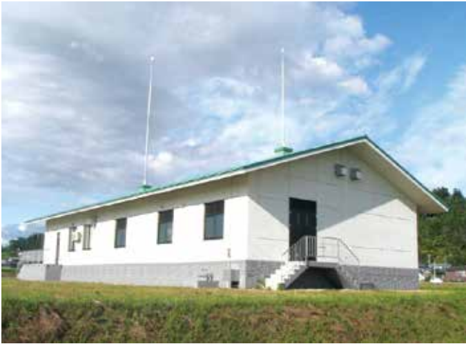
農業集落排水処理施設の整備 金沢地区（横手市）
