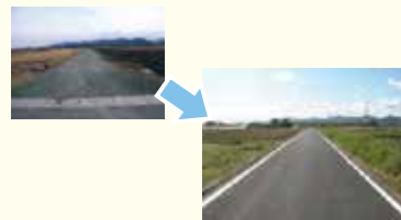
農作業道の整備
