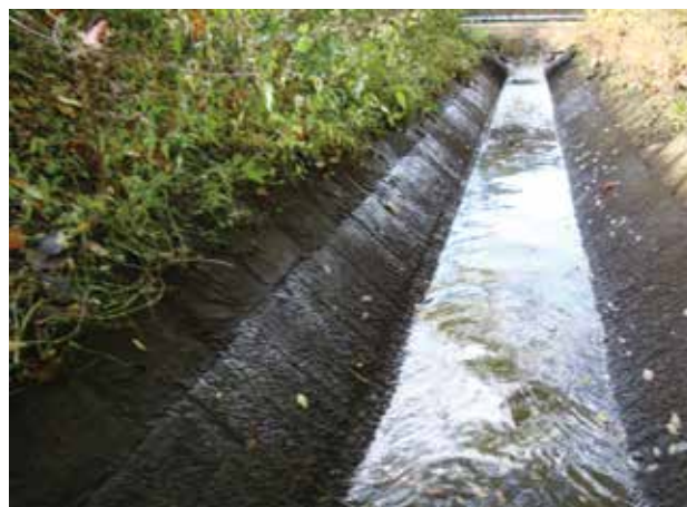
老朽化している幹線用水路
