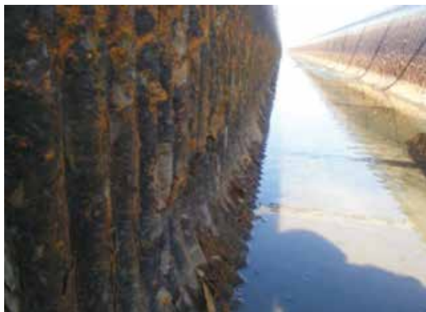
腐食が進行している幹線用水路
