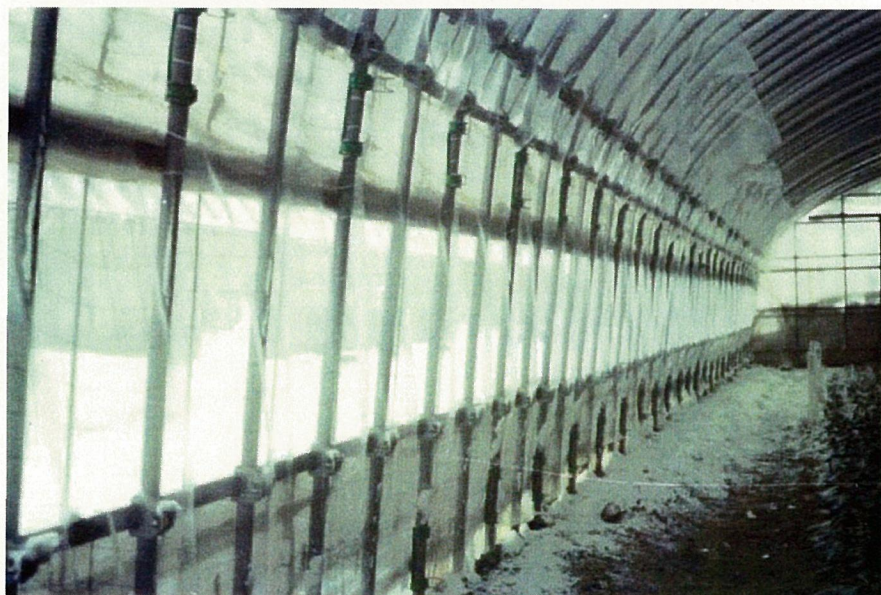
写真② ハウスの内側にハウスパッカーで防風ネットをとめている様子
