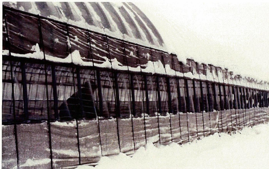
写真① 防風ネットを張り、サイドを開放したハウス
