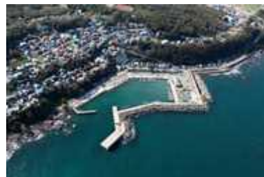
整備が進む畠漁港（男鹿市）
