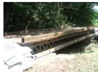
鋼材と木材のハイブリッド木橋
