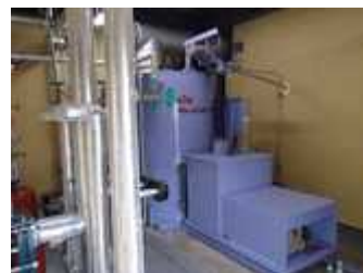
木質バイオマスボイラー
