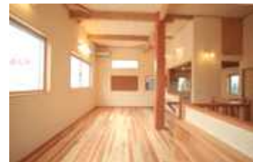
乾燥秋田スギ内装材を使用した住宅
