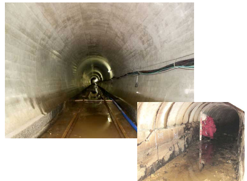
老朽化した水路トンネルの更新整備
