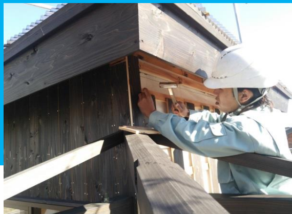
モデルハウスの製作、外壁は杉板で仕上げています。
