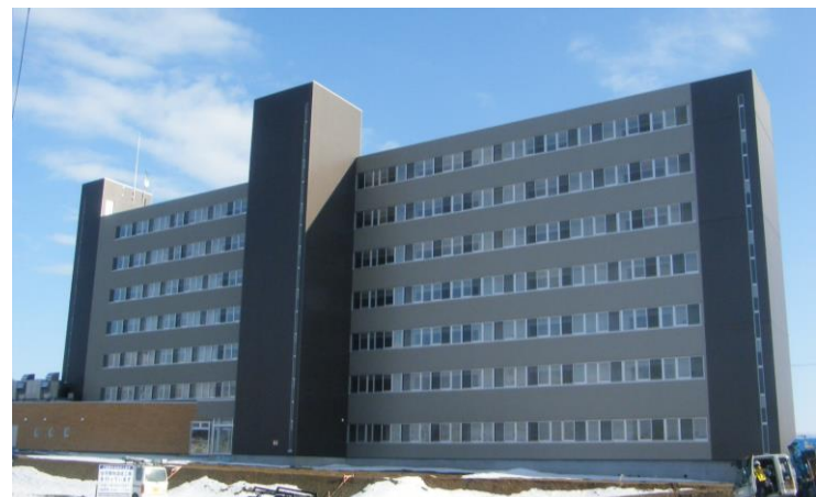
大曲駅前第二地区 都市再生住宅
