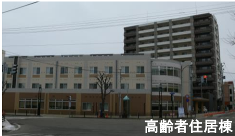
横手駅東口第一地区
