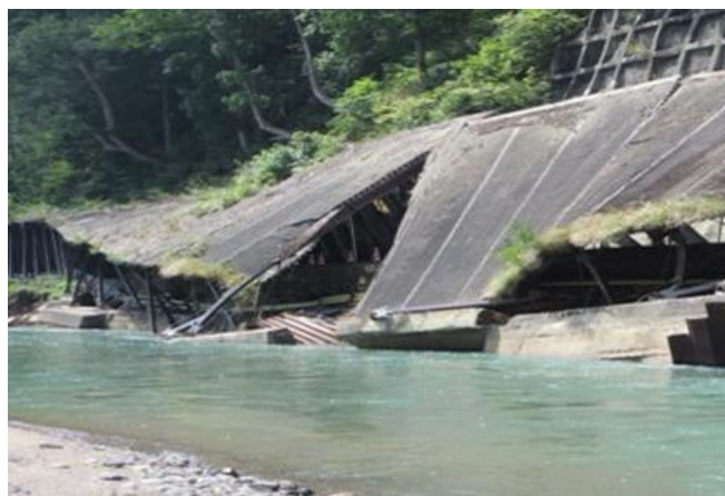
↑ H25.9.15～16 台風18号 国道341号、スノーシェットの崩落
