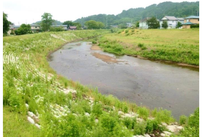
《緑化ブロックを採用した旭川(秋田市)》
