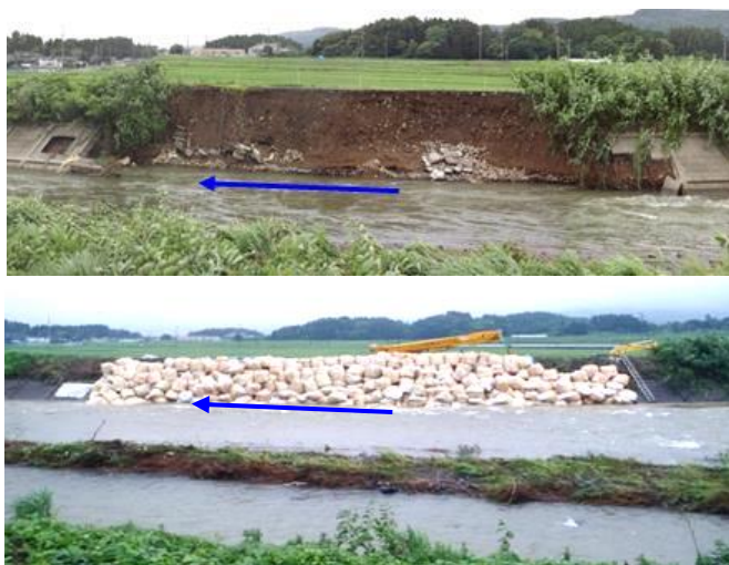
← H25.7.9～13 梅雨前線豪雨 白雪川の護岸決壊と大型土のうによる応急対策
