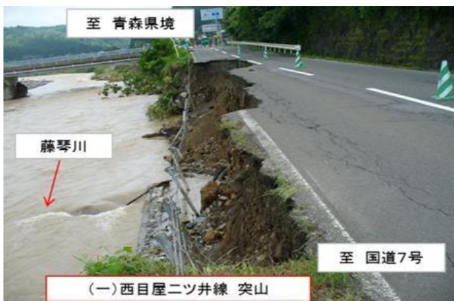
↑ H25.8.9～10 豪雨 県道西目屋二ツ井線の被災
