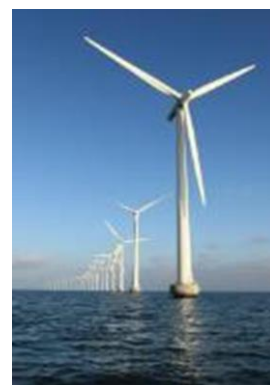
洋上風力発電 (デンマーク)
