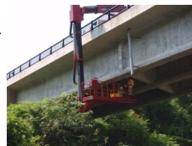
橋梁点検作業の様相
