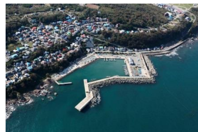
整備が進む畠漁港（男鹿市）
