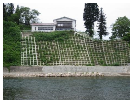
土砂災害対策状況(北秋田市・八幡森地区)
