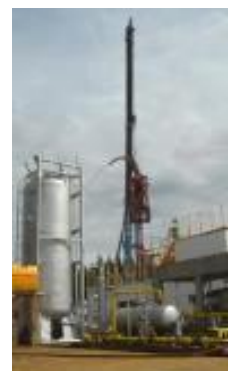
シェールオイル 採掘試験 (由利本荘市)
