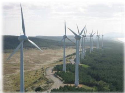
能代風力発電所
