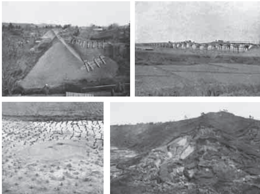
写真2 秋田仙北地震における被害の様子（『震災予防調査会報告82号, 1915年』） 左上：家屋の倒潰 右上：架設工事中刈和野橋の被害 左下：水田の液状化 右下：斜面崩壊
