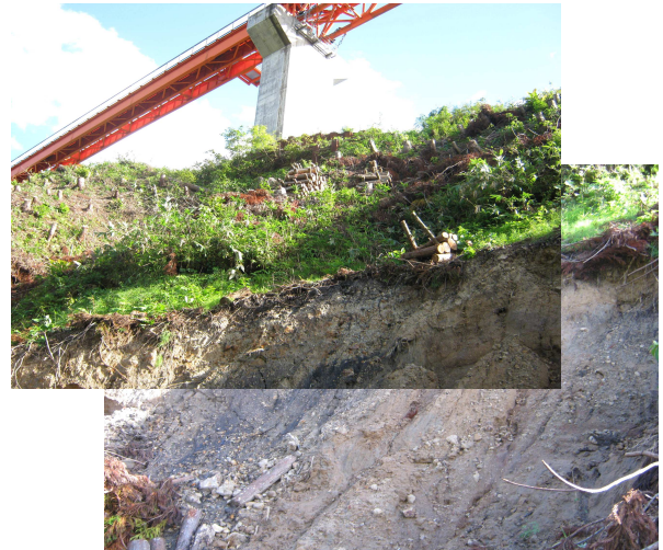
②進入灯橋梁法面
