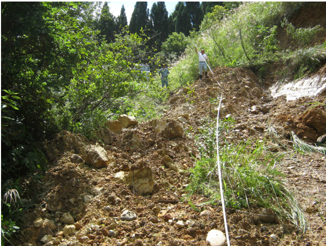
①園地内クロスカントリーコース法面
