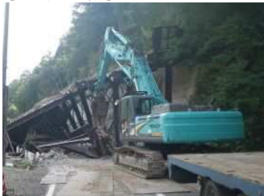
[スノーシェット ® の解体] (9月24日)
