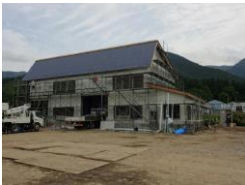
建設中のライスセンター
