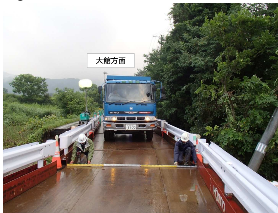
一次復旧完了 (8月10日(土) 5時頃)
