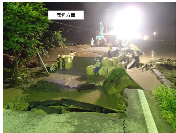
復旧工事業況 (8月9日(金) 20時頃)
