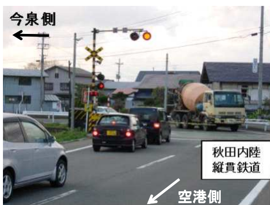
○道路改良[(一)大館能代空港西線 鷹巣西道路工区]
