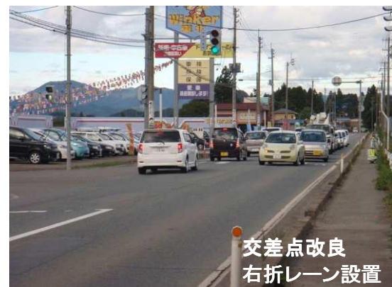
○交差点改良[国道105号石持工区]
