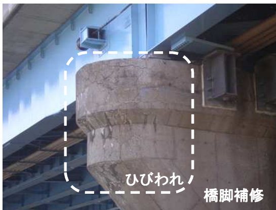
○橋梁補修[国道105号飛鳥大橋工区]
