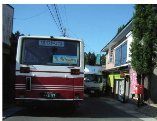
○道路改良[(主)神岡南外東由利線 南外下袋工区]
