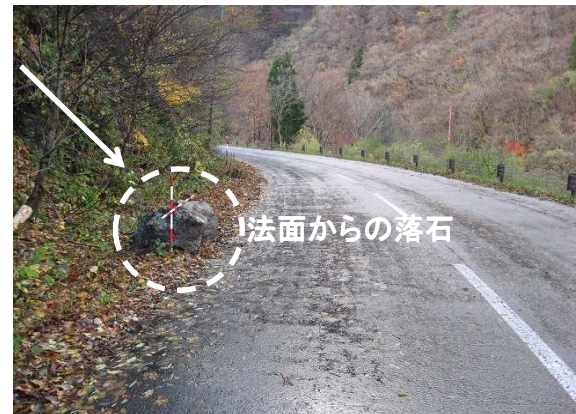
○法面对策[(一)比内森吉線千本杉工区]
