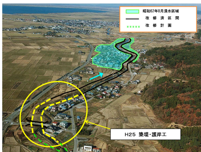
[広域河川改修事業 馬踏川（秋田市）]
