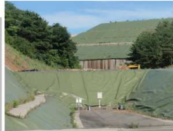
●ため池正面：着手前
