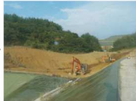
②盛土作業
