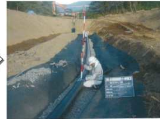
③地下排水管 敷設作業
