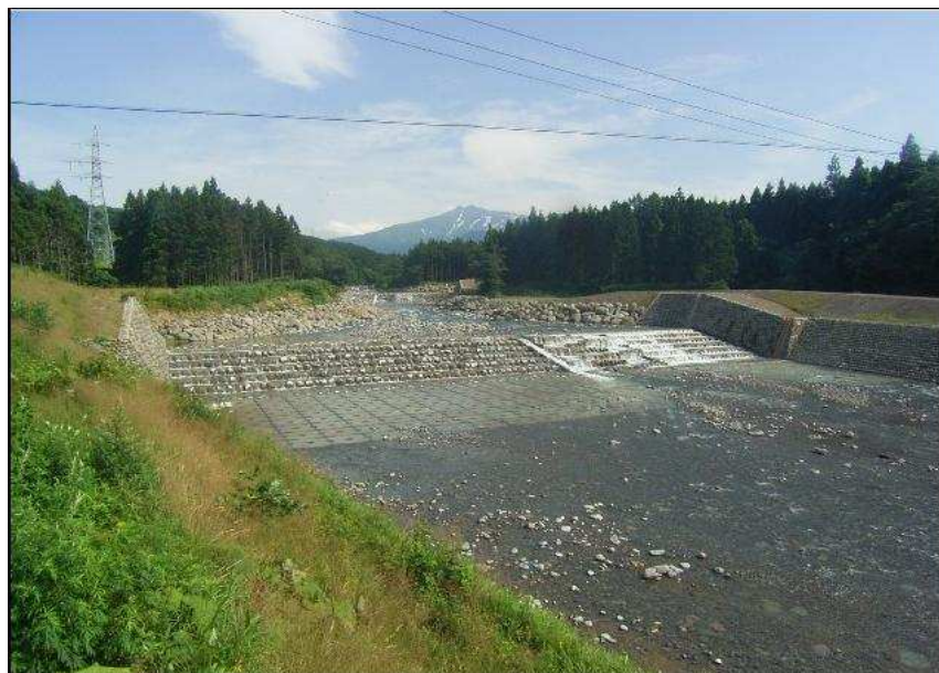
《鳥海山噴火の影響区域にある白雪川で、現地発生材の玉石張りや魚道の設置など環境に配慮した砂防床固工(縦断侵食の防止)》
