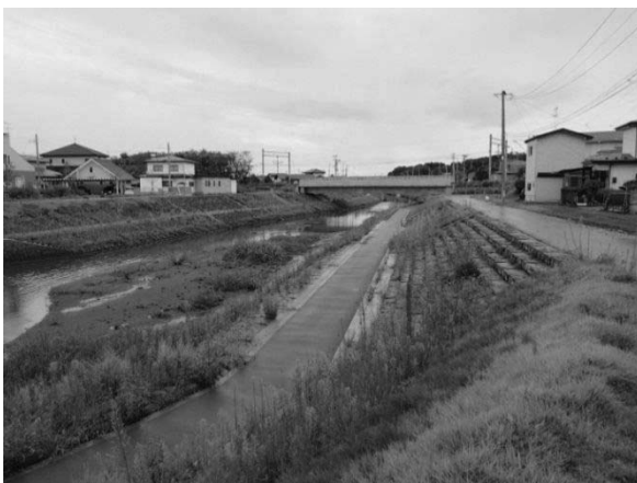
護岸の緑化に配慮した川づくり（草生津川）
