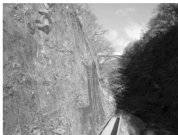
小安温泉園地 園路整備
