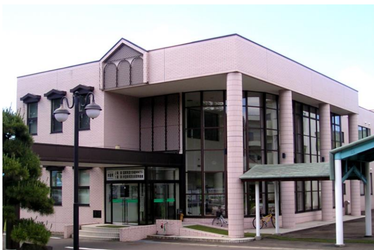
写真 金属鋳業研修技術センター本館
