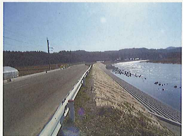
工事完成(H20)
