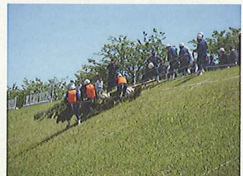
水防訓練(平鹿地域振興局建設部)
