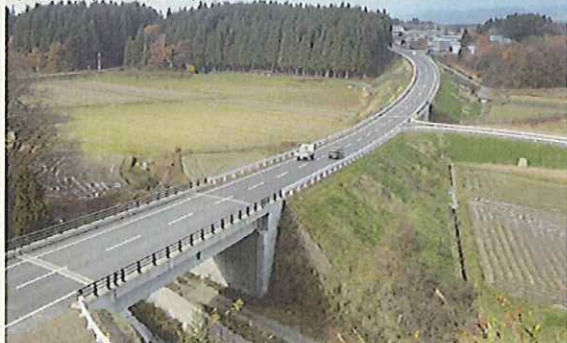
主要地方道 常磐峰浜線 八峰町 石川工区 平成22年10月8日開通
