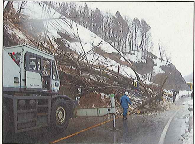
県単道路維持修繕事業(国道105号 倒木処理)
