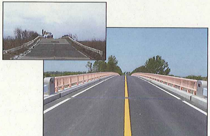
地方特定道路整備事業(道村大川線 大湯村御幸橋)
