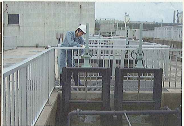
処理施設の点検
