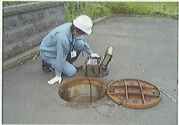
マンホールの点検
