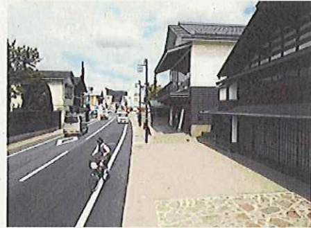
電線類の地下埋設化(羽後町)
