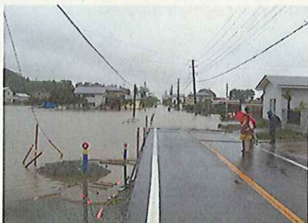
道路冠水状況(秋田市笠岡地区)
