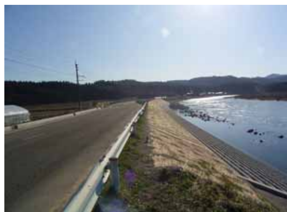
工事完成(H20)
