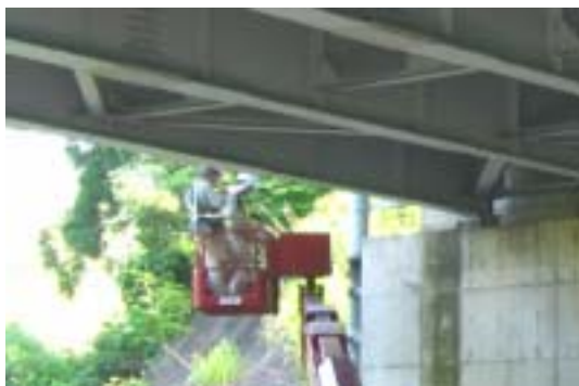
橋梁点検作業
