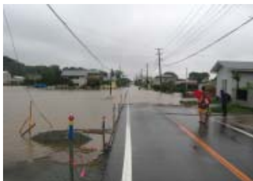
道路冠水状況（秋田市笠岡地区）
