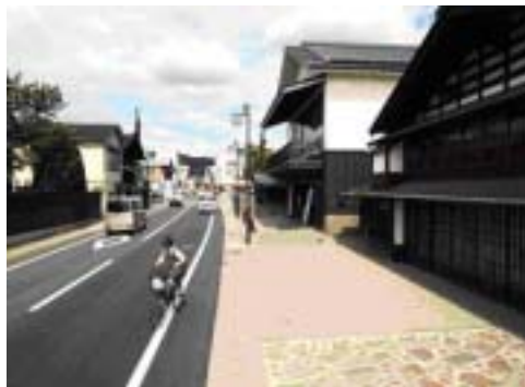
電線類の地下埋設化(羽後町)
