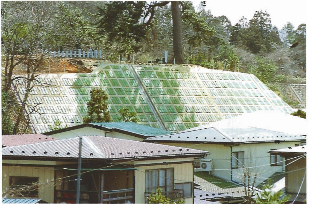
大沢 2 号地区急傾斜地崩壊対策事業（秋田市手形大沢） 平成元年度 L = 99.8m、法枠工 A = 1,010.7㎡
