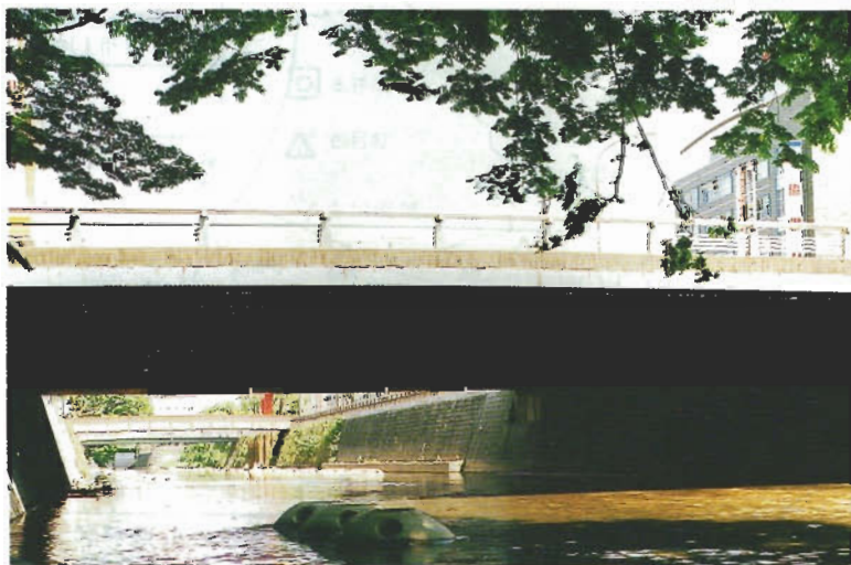
秋田市旭川2丁目橋より上流を望む
