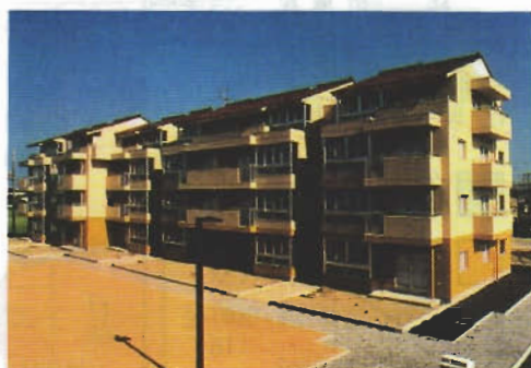
周辺環境を考慮した新規供給 土崎団地（秋田市）
