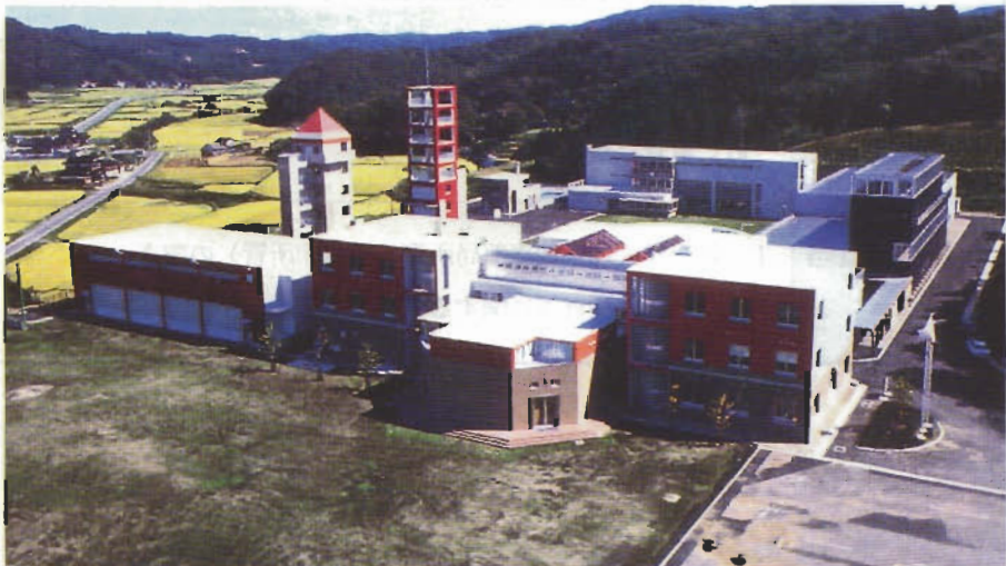
秋田県消防学校（由利郡岩城町）
