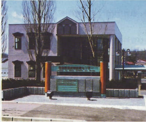
金属鉱業研修技術センター（鹿角郡小坂町）
