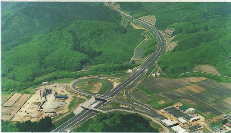
(平成3年7月開通、東北横断自動車道釜石秋田線協和IC付近)
