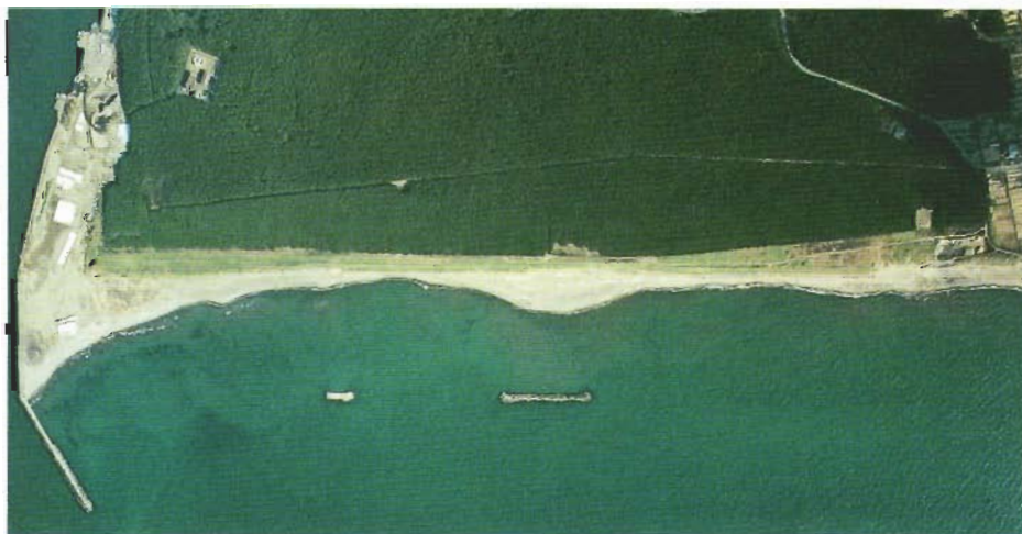
本荘港水林地区離岸堤
