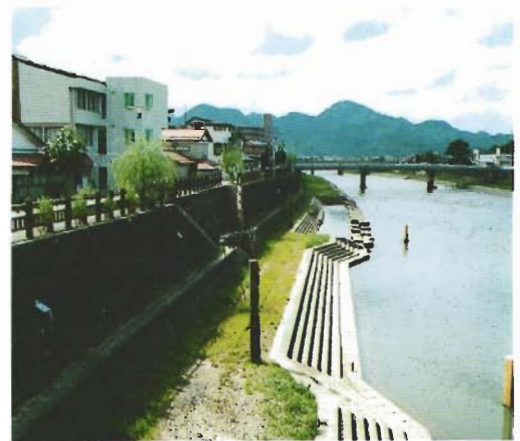
浸水性に配慮した（丸子川）
