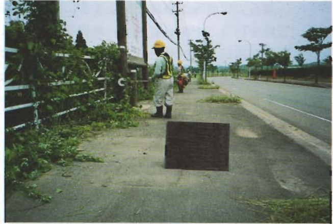
除草作業（県道秋田雄和本荘線 雄和町）
