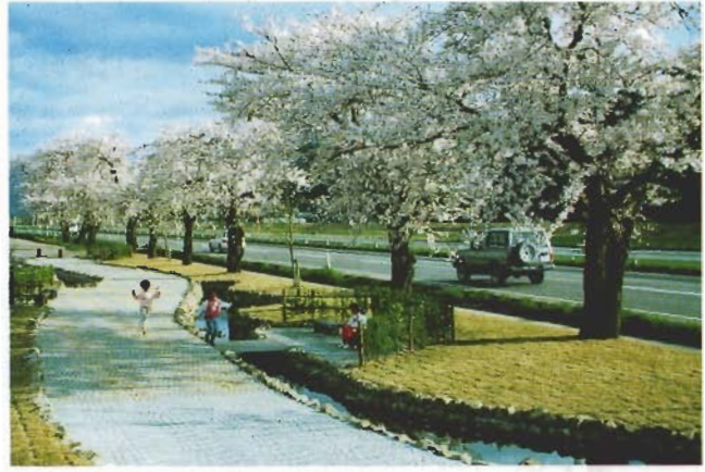
国道108号 雄勝町寺沢
