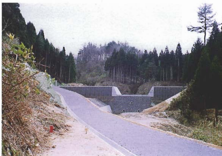
現地発生土利用による鋼製ダム（安田川・男鹿市）
