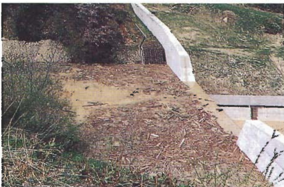
赤川1号砂防ダム (平成7年度完成 H=14.5m L=146m)
