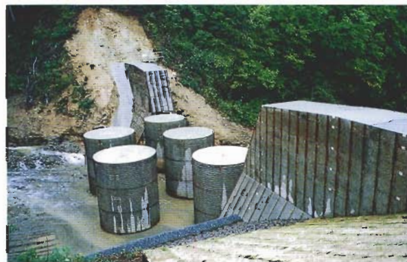
赤川(緊急災関3号)砂防ダム (H=10.0m L=64.0m)
