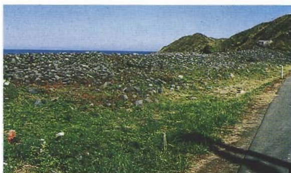
飛の波除石垣
