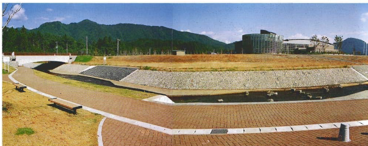
◀災害弱者施設（北部老人福祉総合エリア）の中で景観などに配慮し施工した護岸工 平内沢・大館市▶
