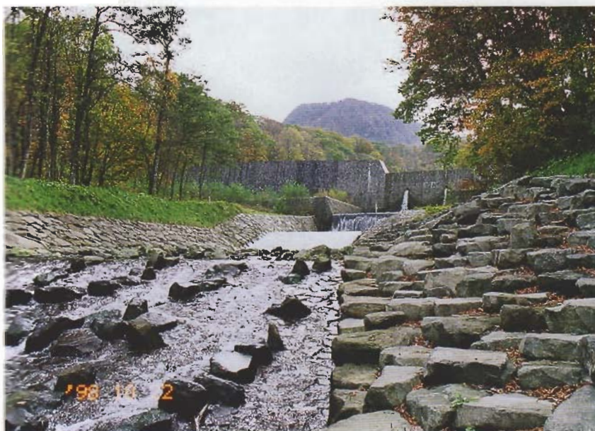
《十和田・八幡平国立公園の中にある土石流危険溪流で景観に配慮し施工した砂防ダム工と護岸工 大川岱・小坂町》
