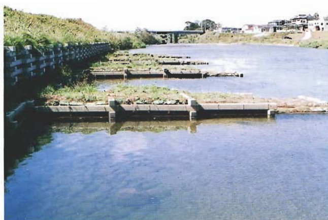
水生生物の避難場所・魚の産卵場所の確保を図った水制工 (岩見川・河辺町)
