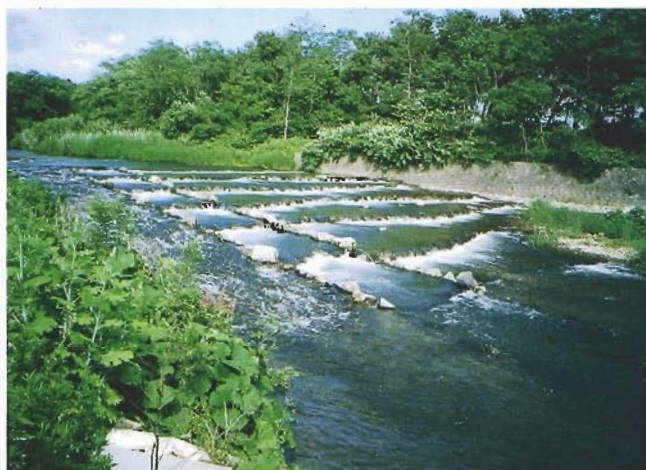
魚の溯上を考慮した魚道 (水沢川・峰浜村)
