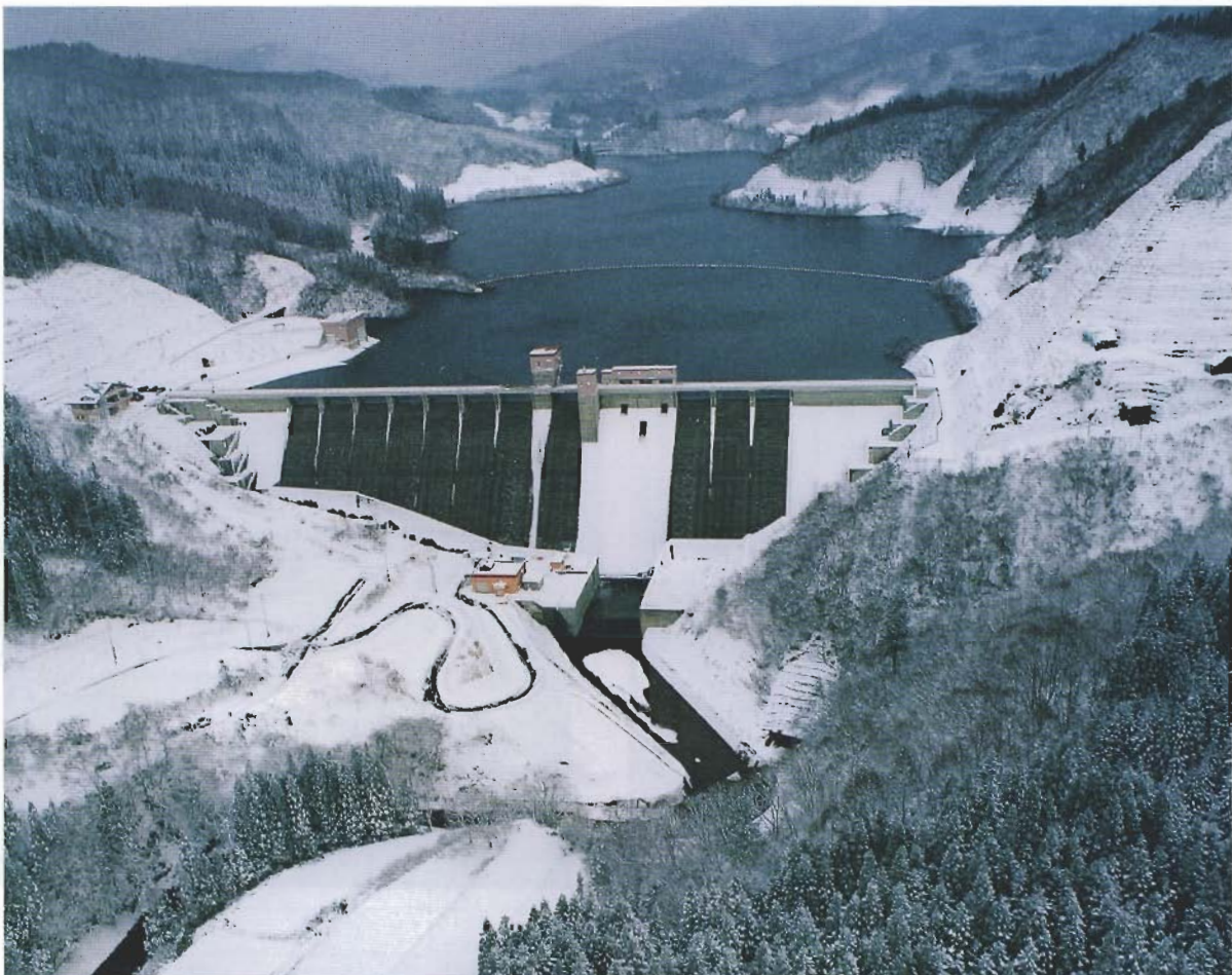
大松川ダム（最高水位到達：H10.12.19）
