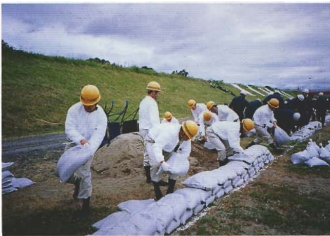
水防訓練（雄勝土木事務所管内）
