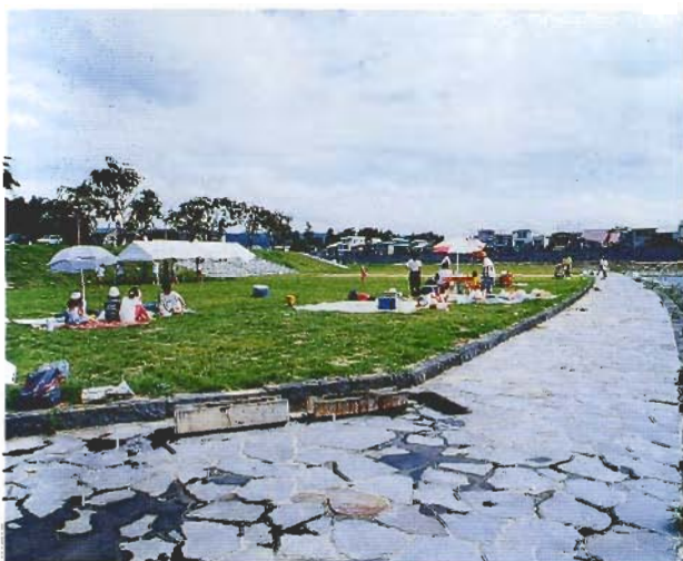
ふるさとの川整備事業 （横手川・横手市）
